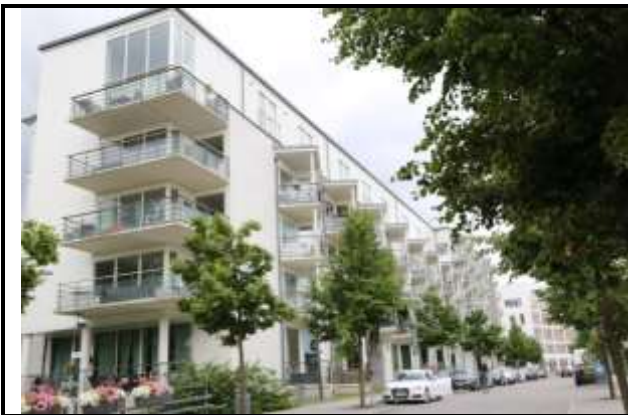
▲透過大面積的玻璃採光，減少室內光源及暖氣的使用量。玻璃則使用加厚的特殊玻璃，減少熱能散失，但仍能兼具採光功能。
