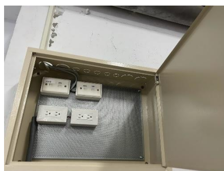
施工後-增設具鎖之箱體及 cat6 插座(前後各設置一櫃)
