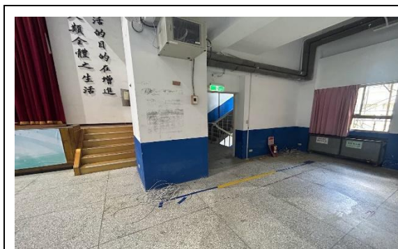
施工前-臨時線凌亂，地面膠帶固定
