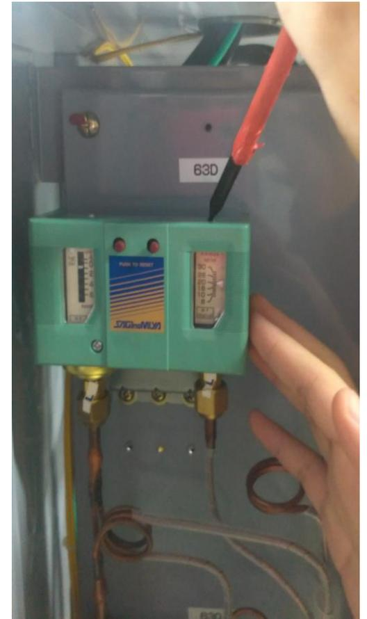
蓮(連鎖保護元件測試):切(切延時電驛);油(溫壓開關);過(過載保護器);高(高壓開關);
