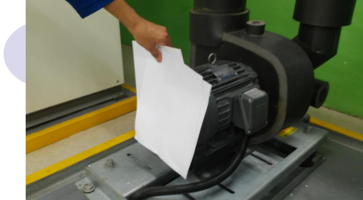
開完水閥測冰水泵與冷卻水泵轉向與壓力
