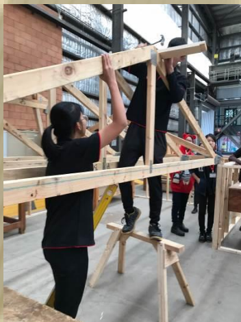
屋頂木桁架組裝-1
