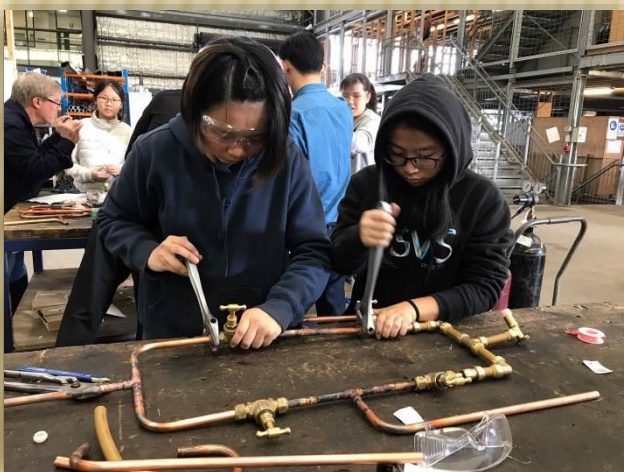
冷熱水管配管實作
