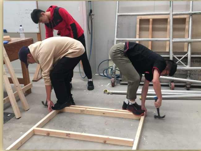
木構造牆組立實作-3
