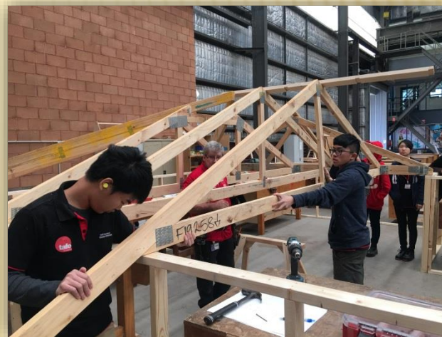
屋頂木桁架組裝-3
