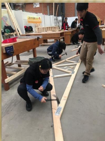
屋頂木桁架製作-3
