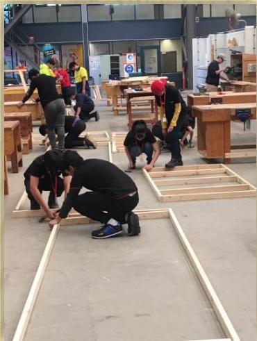
木構造牆組立實作-1
