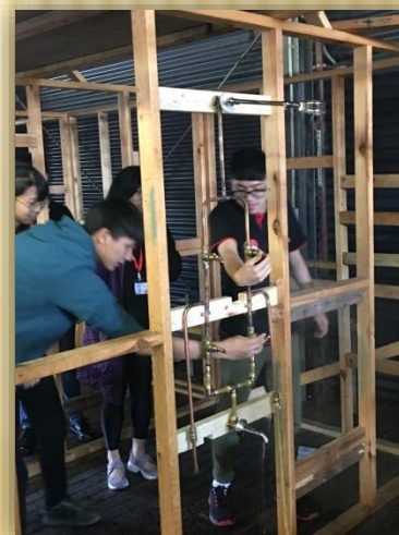
冷熱水管組件安裝及壓力試驗
