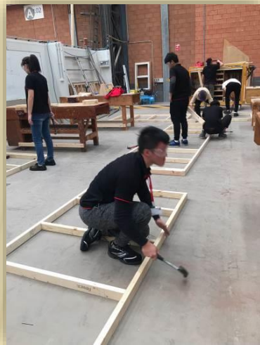
木構造牆組立實作-2
